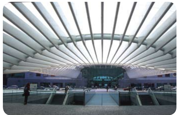
Figura 2 - Lisbona, Expo, fermata "Oriente". Un generoso angolo di ripresa di f. 2,8 24mm valorizza la struttura architettonica e mostrando in che modo evolve all'esterno, lascia visibili le figure umane e le auto. Sullo sfondo, a seguire, ancora strutture. La foto è stata scattata a f 11, 1/60" con pellicola diapositiva Kodak EKTACHROME 64 ISO, digitalizzata con scanner per pellicola.
